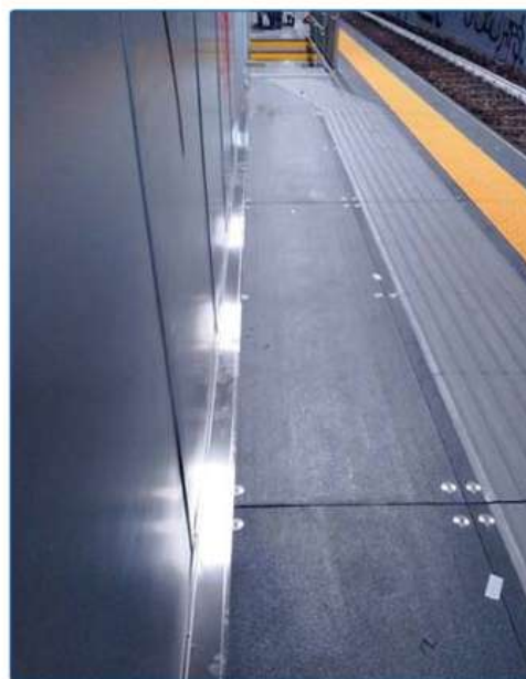
Fig. 3 - Particolare degli angolari di battuta integrati con il pavimento
