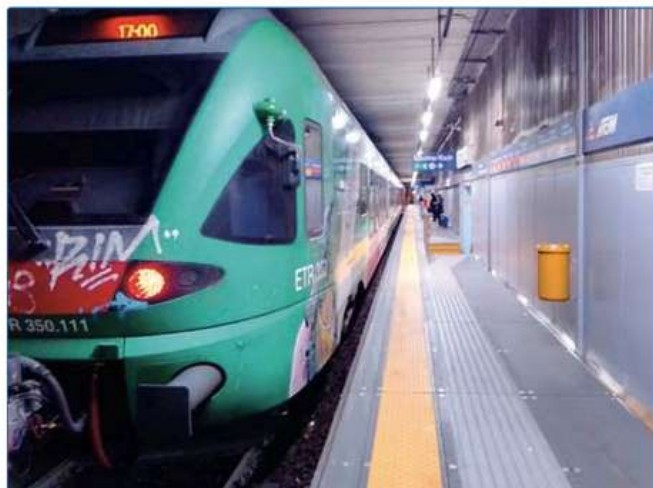
Fig. 4 - La banchina con il pavimento galleggiante FIDA risulta essere a raso con il piano di calpestio del treno
